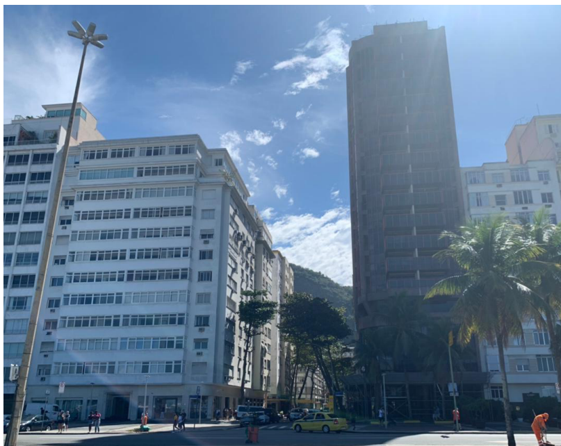
Figura 3 - Entrada do Beco das Garrafas. Fonte: Simone Feigelson.
