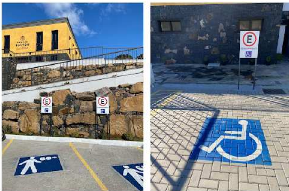
Figura 9 - Vagas de estacionamento para pessoas com deficiência e idosos na Casa di Pasto Fonte: IFRS e Salton (2022)
