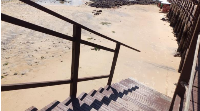
Figura 5. Escada no calçadão de acesso à praia.
