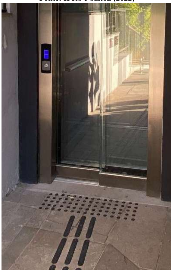
Figura 8 - Adoção de elevador com sinalização na Casa di Pasto Fonte: IFRS e Salton (2022)
