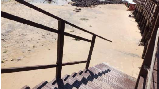
Figura 5. Escada no calçadão de acesso à praia.
