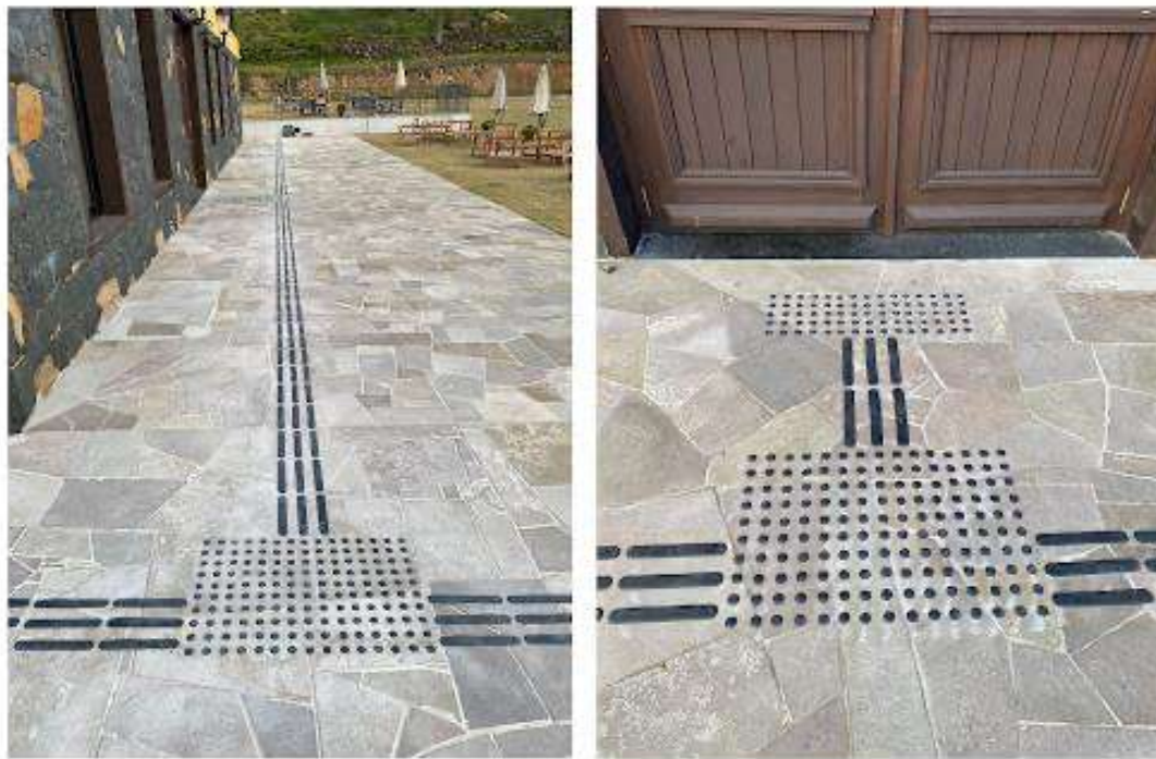
Figura 4 - Piso direcional e de alerta utilizado na Casa di Pasto Fonte: IFRS e Salton (2022)
