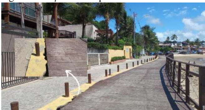
Figura 6. Calçadão de Pipa.
