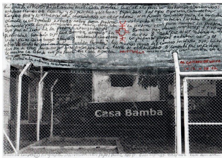
Figura 9 – Ruínas do lado da central elétrica.
