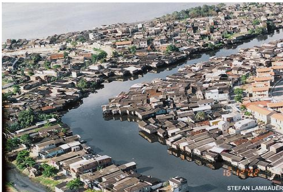
Figura 2 - Vista aérea do Dique da Vila Gilda
