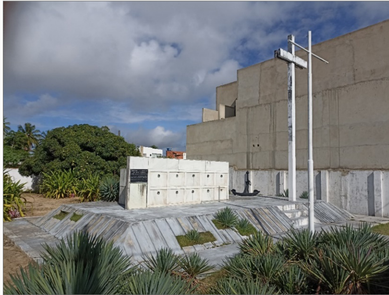
Figura 1. Novo Cemitério dos Naufragos. Fonte: Foto do Autor. 2022. Povoado Mosqueiro, Sergipe.
