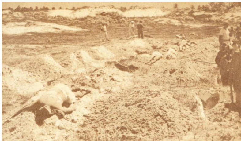
Figura 3. Vala coletiva dos naufragos. Praia de Sergipe. 1942. Fonte: AGRESSÃO, 1943 11 .
