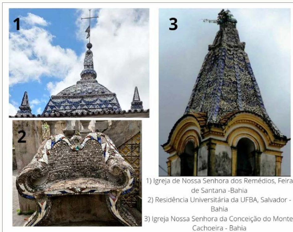
Figura 1 – Embrechados em torres sineiras e banco de jardim. Fonte: Fotos Santos Neta, 2022.
