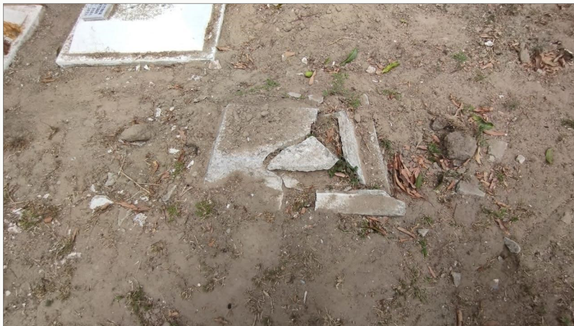
Figura 12: Descaso conservacional - Exemplo 2.
