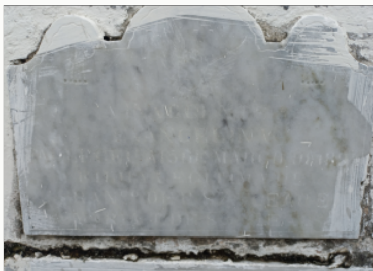
Figura 4: Lápide degradada por derrame de pintura em pequena parte da sua superfície
