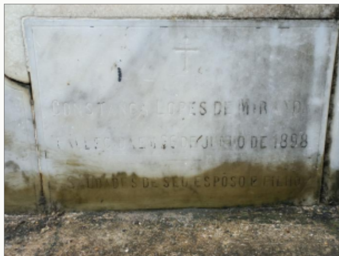
Figura 2: Lápide degradada pela descoloração e presença de colônia biológica
