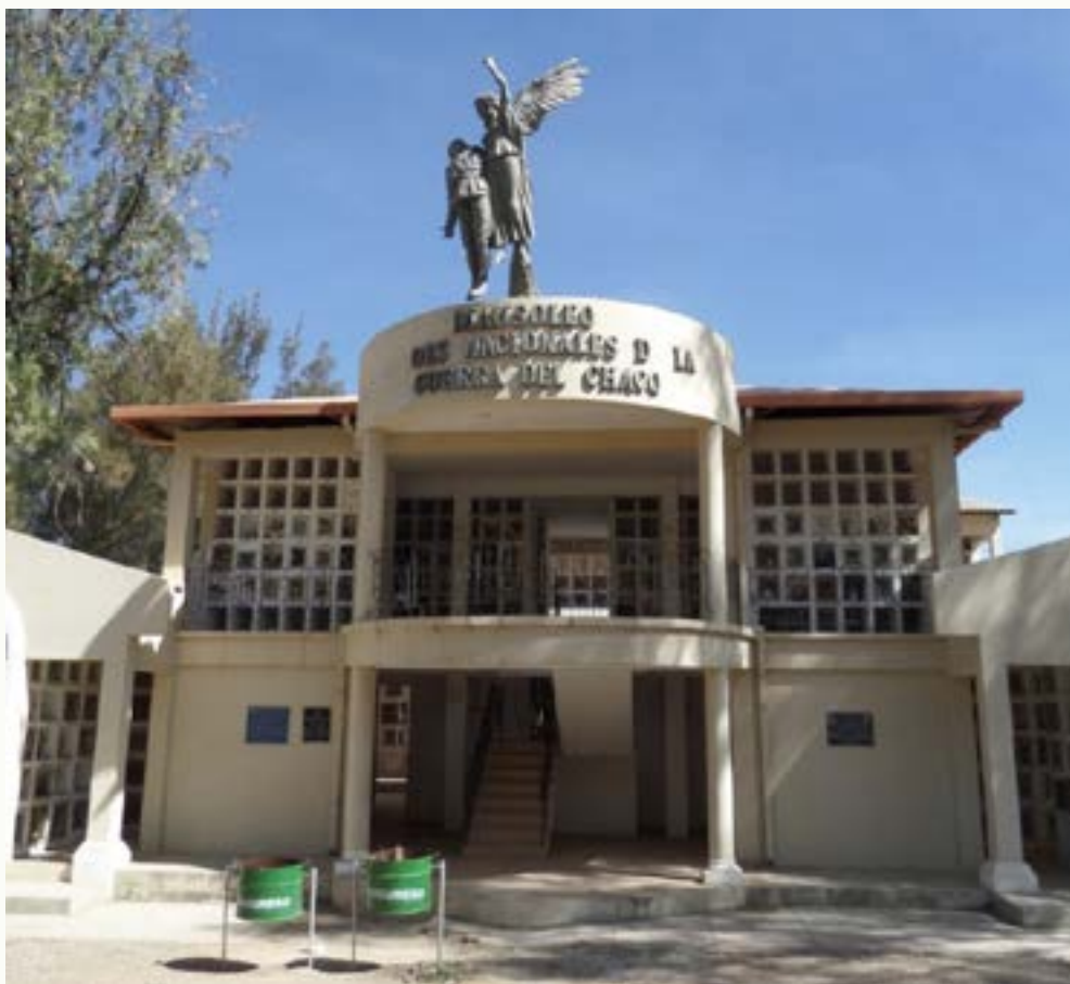
Figura 8. Frontal de pavilhão (Cementerio General de Cochabamba)
